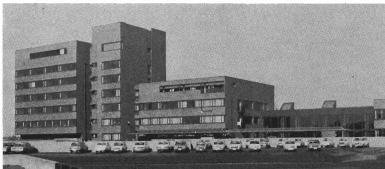
正面、前庭に設けられた駐車場から本館を眺めたもの、 向って左端が病棟、中央が管理棟、右端が外来棟。
