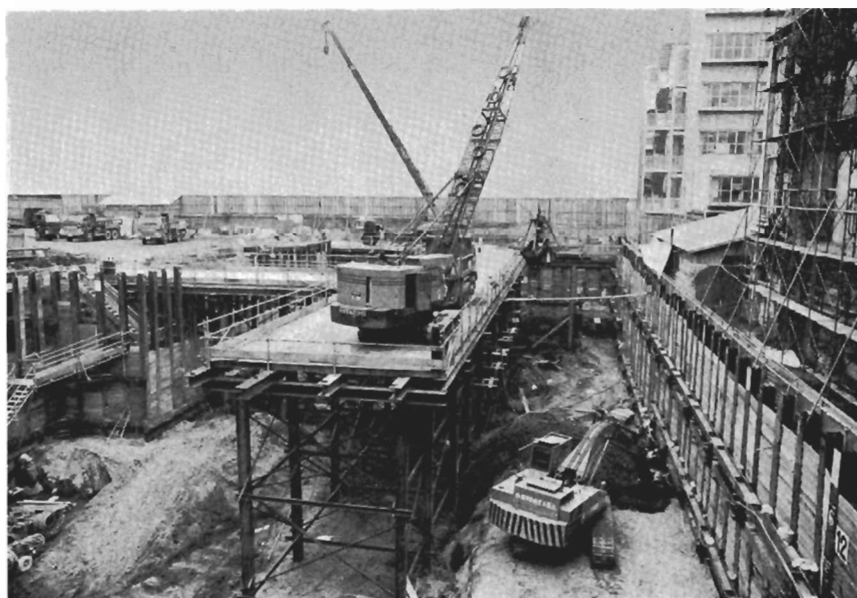
基礎工事中の新研究所、昭和54年3月
