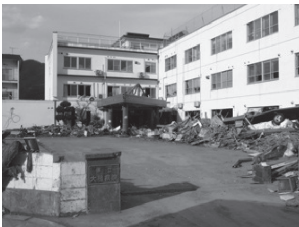
被災した県立大槌病院
