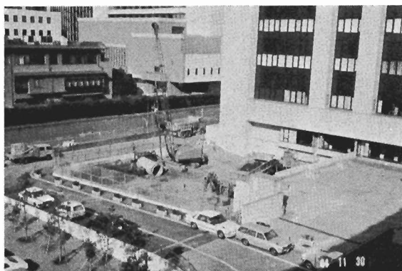
国際研究交流会館建設現場
